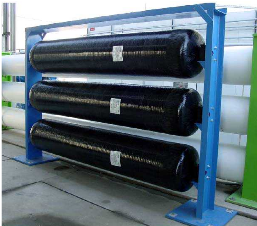
<그림 3.10. 수소충전소 내 실린더 형태 고압 수소저장용기>
