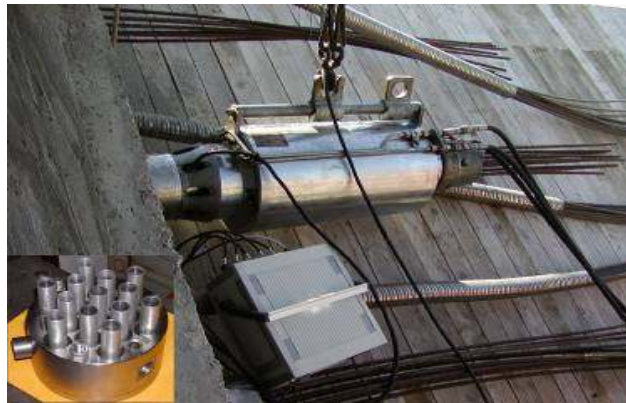
<그림 2.3-13> 앵커리지 헤드의 센서 설치
