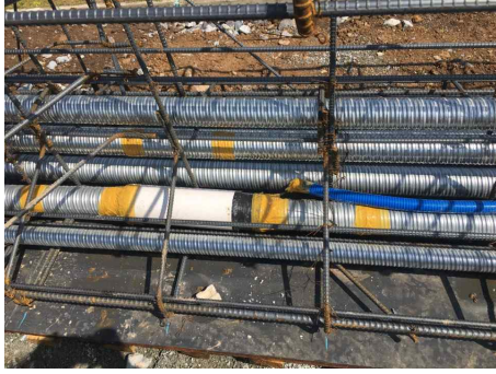
(b) EM 센서 설치
