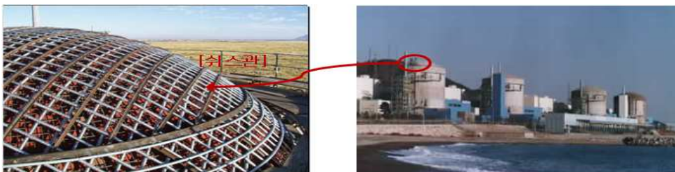
<그림 3.1-2> 원자력 발전소 구조물의 쉬스관 모습
