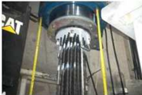
<그림 3.1-1> 원자력발전소 원자로격납건물에서의 PS 긴장 및 긴장력 계측 과정
