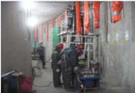
<그림 3.1-1> 원자력발전소 원자로격납건물에서의 PS 긴장 및 긴장력 계측 과정
