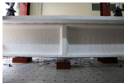
(b) 균열 양상
