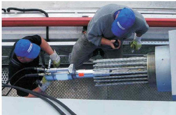
<그림 3.1-3> 케이블 교량의 Lift-off test 모습
