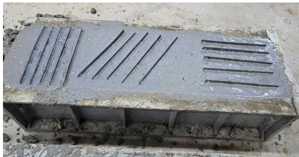
[균열 유도판 삽입]
