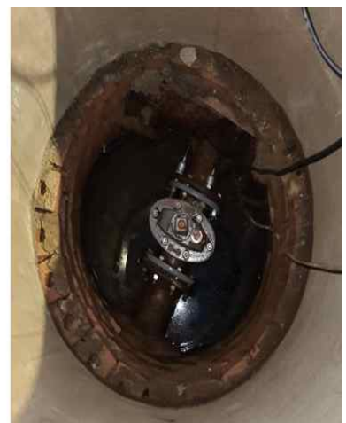
[그림 3.6] 기존 볼트 및 실험용 스마트볼트, 현장 설치용 스마트볼트, 스마트볼트 설치 모습
