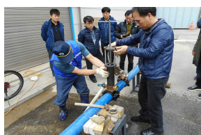
㉡ 천공 후 지관 기밀장치 설치
