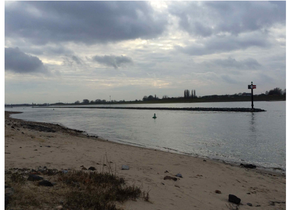
그림 3-12. 하천 양안을 보호하기 위한 횡방향 및 종방향 제방
