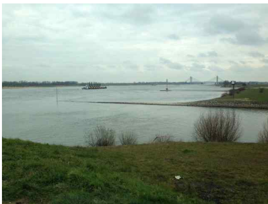
그림 3-12. 하천 양안을 보호하기 위한 횡방향 및 종방향 제방
