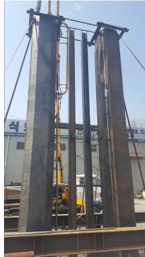
OCFT 강관 완성 (Erection 후)
