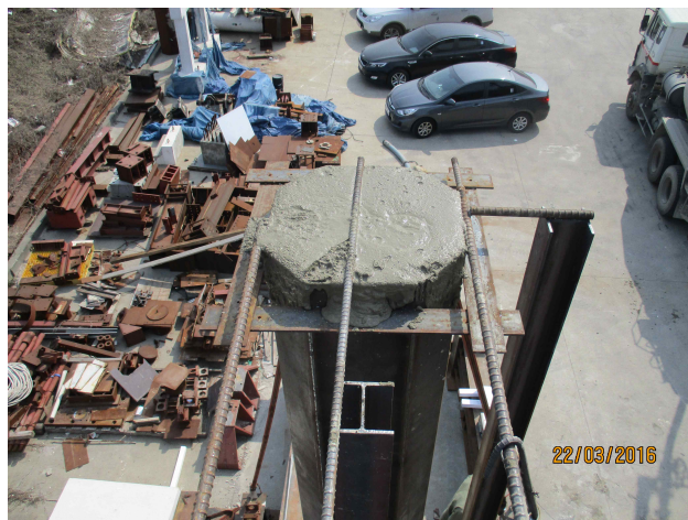
콘크리트 타설 후 모습
