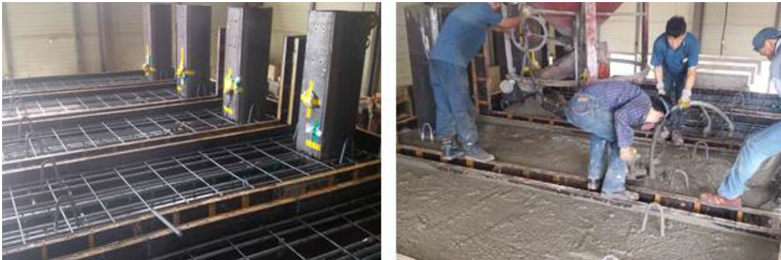
그림 3.2.12 OCFT기둥-보 외부 접합부 실험체 제작 현장
