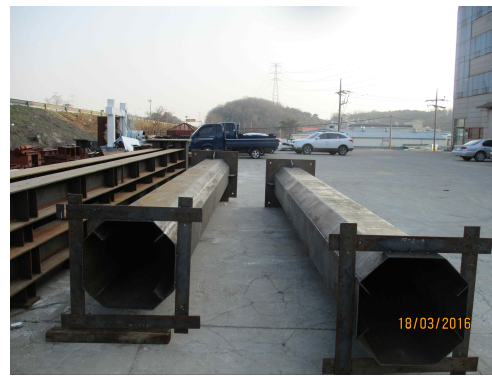
OCFT 강관 완성 (Erection 전)
