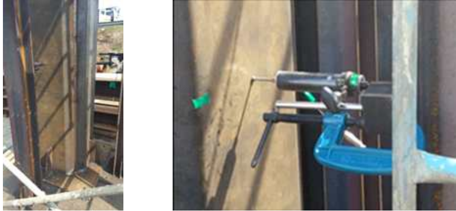
그림 3.1.11 실험체에 LVDT가 설치된 모습
