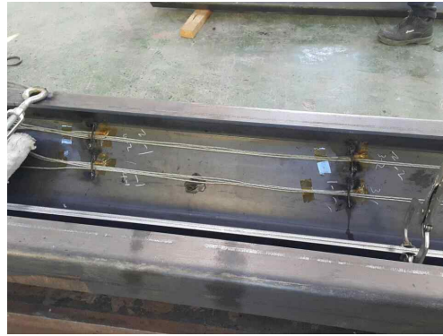
열전대 센서 설치
