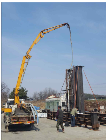
펌프카를 통한 콘크리트 타설
