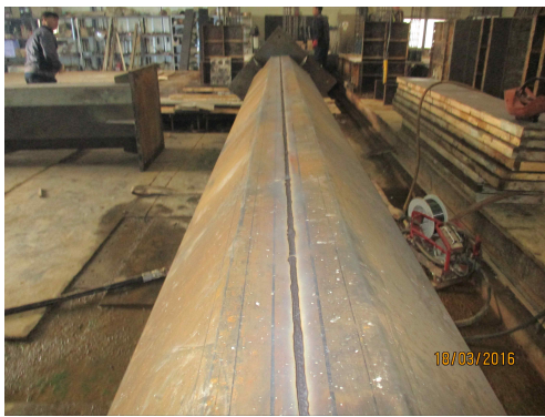
OCFT 강관 가용접 후 모습
