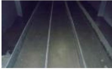
<강박스 거더 내부>
