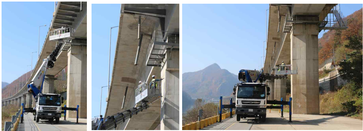
고소차를 이용한 교량 점검
