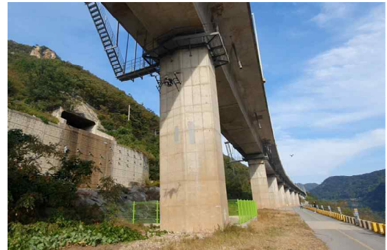
점검 사진(바닥판 및 거더 외부)
