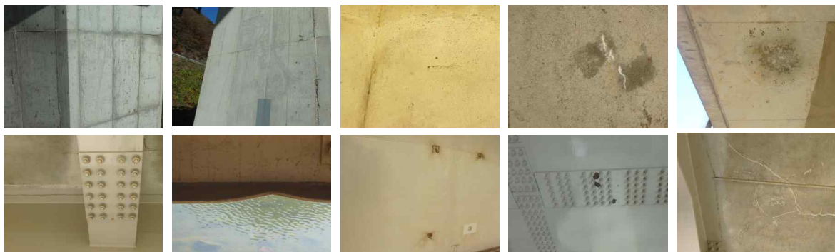
인력 점검에 의한 손상 탐지 사진
