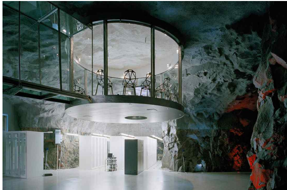
(a) Pionen Data Center (스톡홀름)
