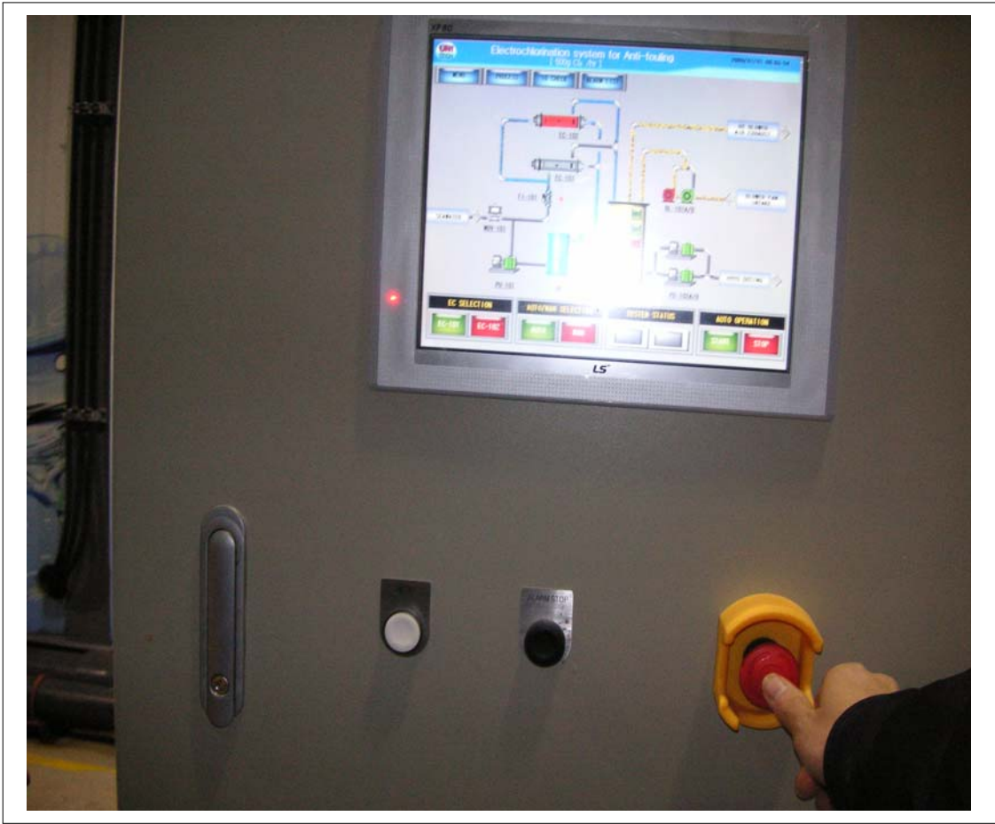
[그림 3.3.5] Functional test(According to Clause 18.6)
