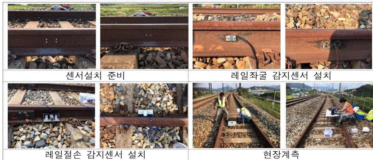
그림 2.31 레일 좌굴/절손 센서 설치 절차
