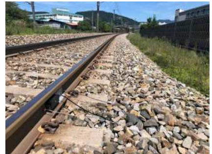
(c) 센서 설치
