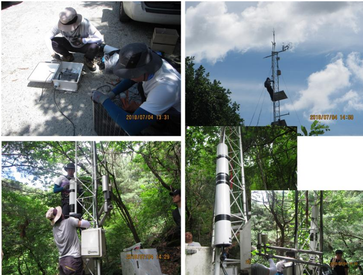
Fig. 3.2.70 기존 운영중인 설마천 유역 Flux-tower와 신규 설치된 CRNP
