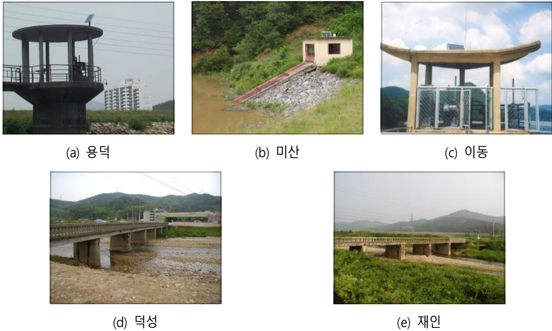
Fig. 3.2.38 저수위 및 하천수위관측소(이동 시험유역)
