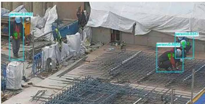
그림 83. Aspect Ratio와 Optical Flow를 활용해 개선된 다수 작업자 추적 예시.
