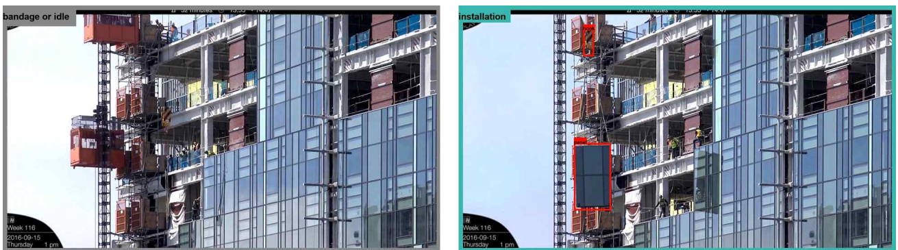
그림 84. 패널 인식 오류 예시(좌: 복귀를 결속으로 오분류, 우: 인양을 설치로 오분류).
