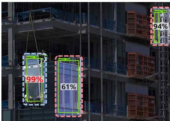
그림 46. 인식 신뢰도 기반 설치대상 패널 선정 예시.
