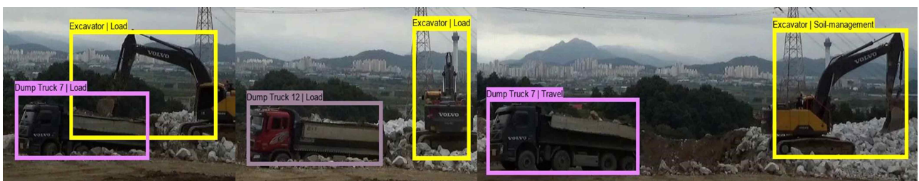
그림 51. 장비 작업상태 자동 인식 모델 시험 결과(정확도 84.1%) 예시.
