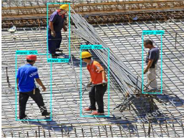
그림 44. 투입 작업자 현황 자동 인식 모델의 성능 시험 결과(정확도 94.7%) 예시.
