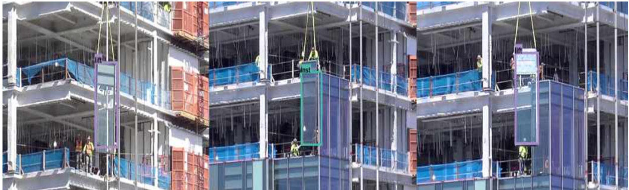
그림 57. 투입 자재 작업상태 자동 인식 모델 시험 결과(정확도 88.3%) 예시.
