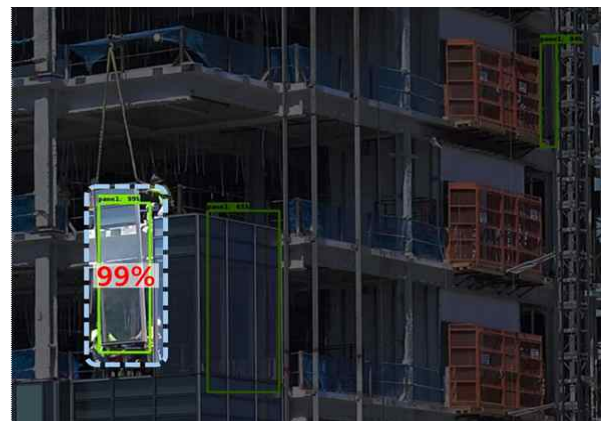
그림 46. 인식 신뢰도 기반 설치대상 패널 선정 예시.
