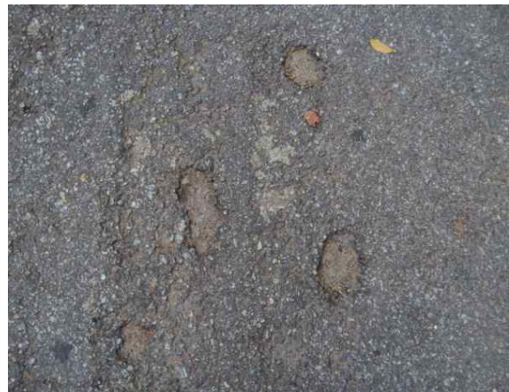
〈그림 3.62〉 표면 노후화 및 일부구간 포트홀 발생
