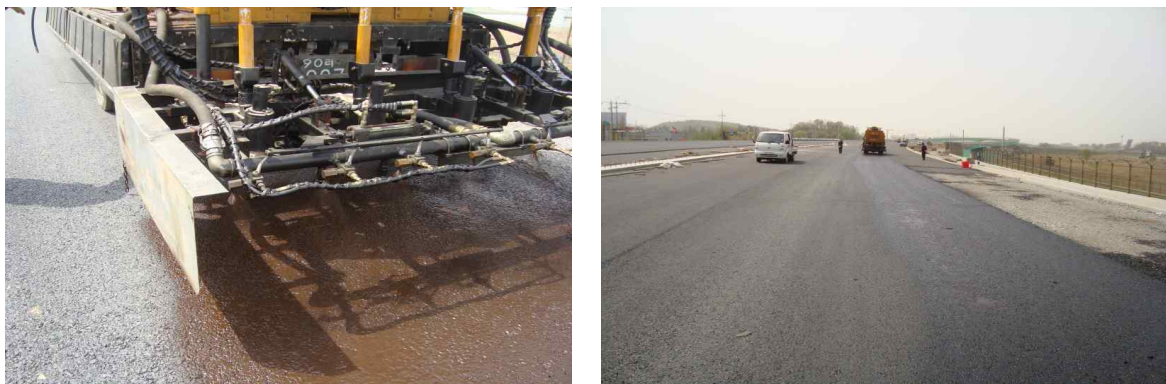
〈그림 3.86〉 장비의 연속 가동 시험
