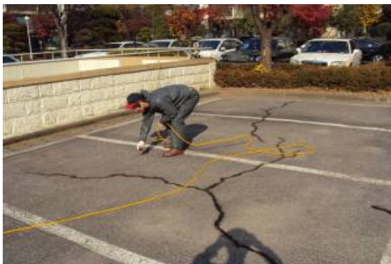
〈그림 3.70〉 포그셀 적용을 위한 표면정리 및 인접시설물 보호
