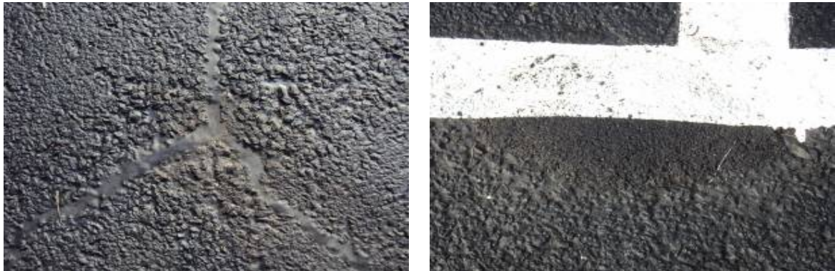
〈그림 3.79〉 균열 보수 및 부분 보수구간
