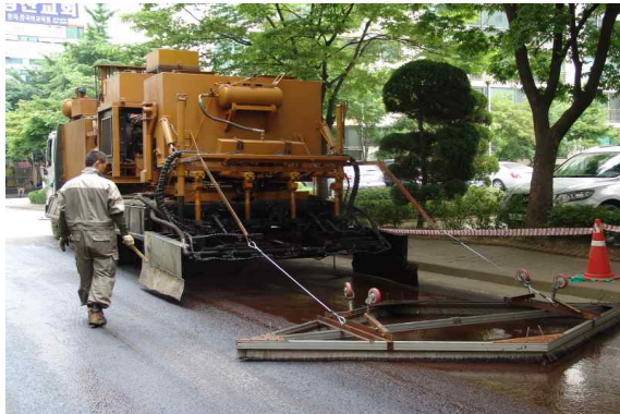
〈그림 3.93〉 장비를 이용한 단지 내 포장 시험시공
