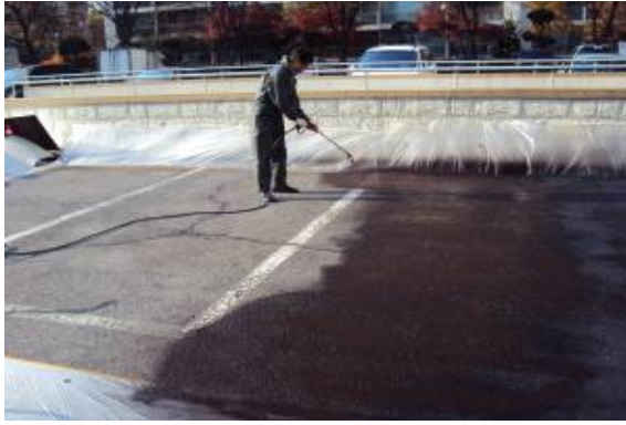
〈그림 3.71〉 포그셀용 개질 유화 아스팔트 살포 및 양생
