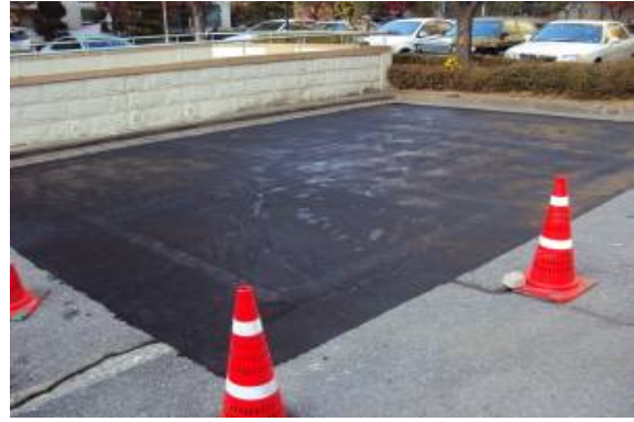
〈그림 3.71〉 포그셀용 개질 유화 아스팔트 살포 및 양생
