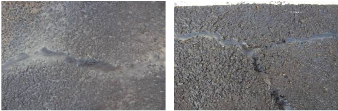
〈그림 3.81〉 균열 보수 구간
