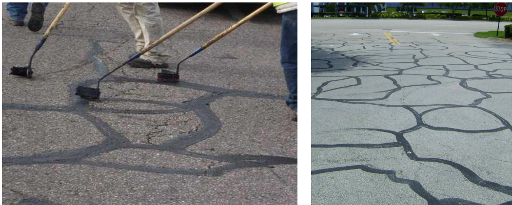
<그림 2.1> 균열 처리 공법 적용예
