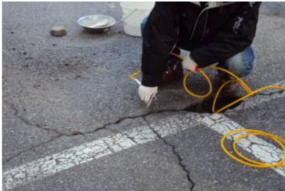
〈그림 3.68〉 균열부 청소 및 고무 아스팔트 충전
