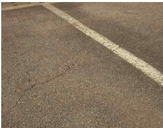
〈그림 3.56〉 균열 파손 및 표면 노후화
