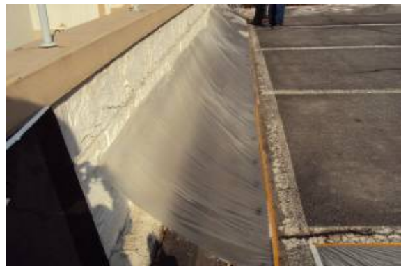
〈그림 3.70〉 포그셀 적용을 위한 표면정리 및 인접시설물 보호
