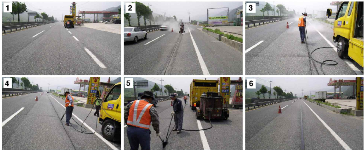
〈그림 2.6〉 건설 신기술 220호 시공 과정
