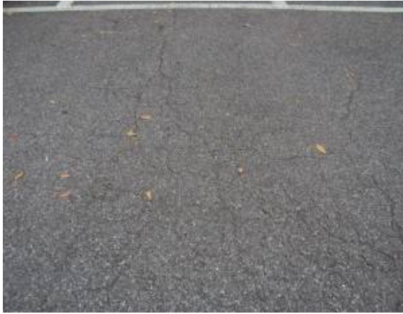
〈그림 3.61〉 균열 파손 및 부분 융기
