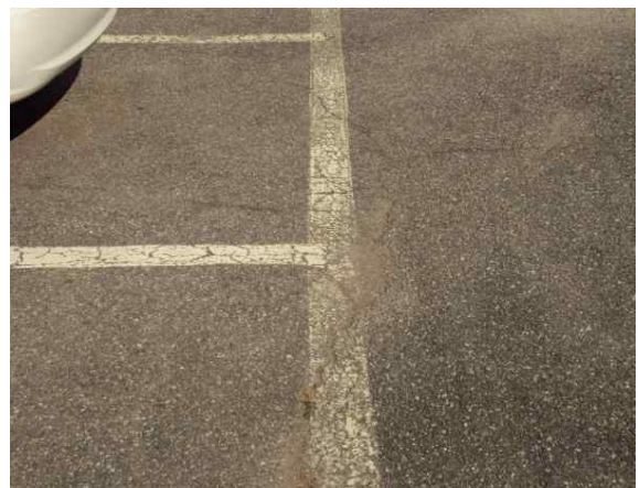
〈그림 3.56〉 균열 파손 및 표면 노후화
