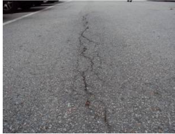
〈그림 3.61〉 균열 파손 및 부분 융기
