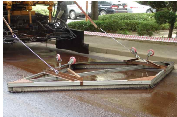
〈그림 3.93〉 장비를 이용한 단지 내 포장 시험시공
