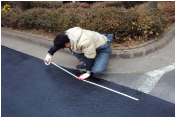
〈그림 3.72〉 기존 차선부 마킹 및 도색
