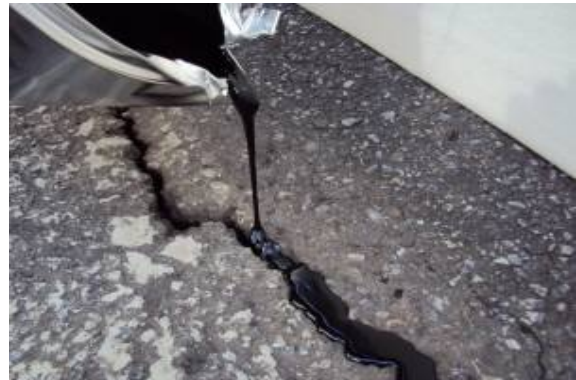
〈그림 3.68〉 균열부 청소 및 고무 아스팔트 충전
