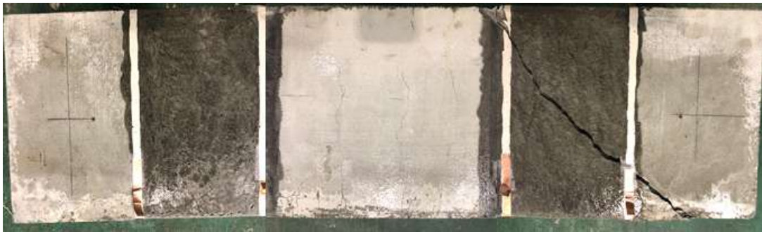
Fig. 37 - 자기감지 섬유보강 콘크리트의 휨 인장 하중 하에서의 전단 파괴 형상
