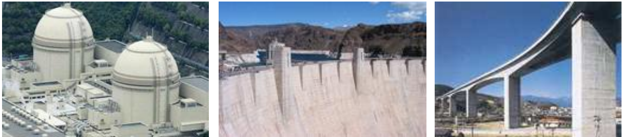
<지속적인 유지관리가 필요한 대표적인 콘크리트 구조물>
