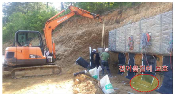
(2) 현장 발생토를 이용한 접이음길이 보호
