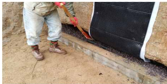
(8) 연직배수재 설치 및 쇄석채움
