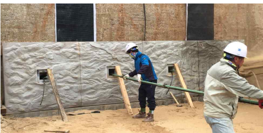
(11) 1단 네일 설치
