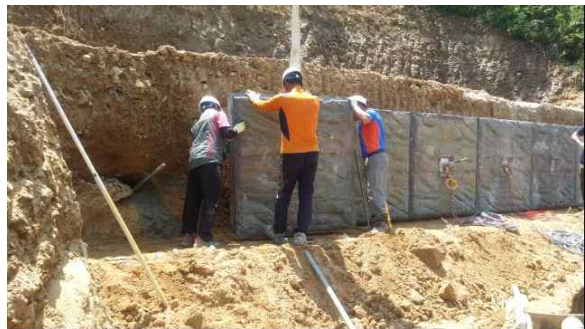
(8) 1단 옹벽 설치
