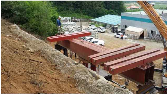
(11) Guide Beam 설치
