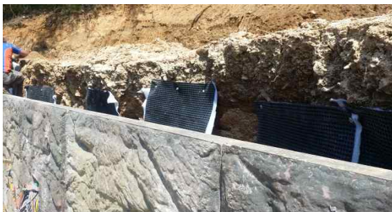
(1) 최상부 배수재 설치
