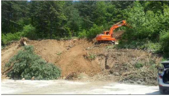
(1) 주변정리 및 상부 소단 조성
