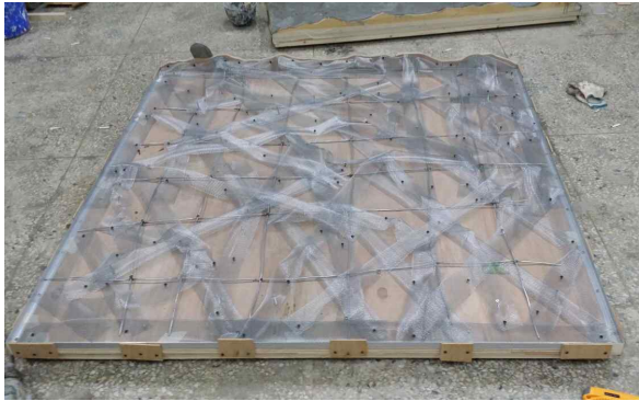
(1) 패널 규격을 고려한 기본틀 작업
