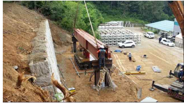
(10) Main Beam 설치
