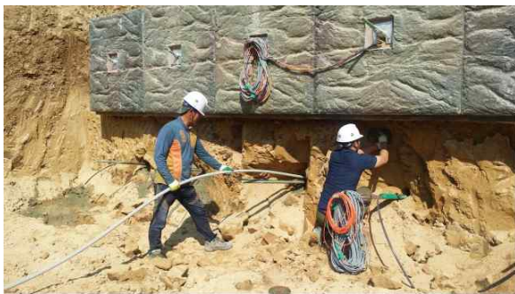
(13) 쏘일네일링 설치 및 그라우팅
