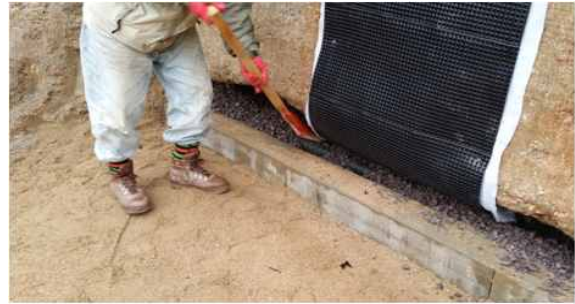
(2) 배수재 설치 및 잡석채움
