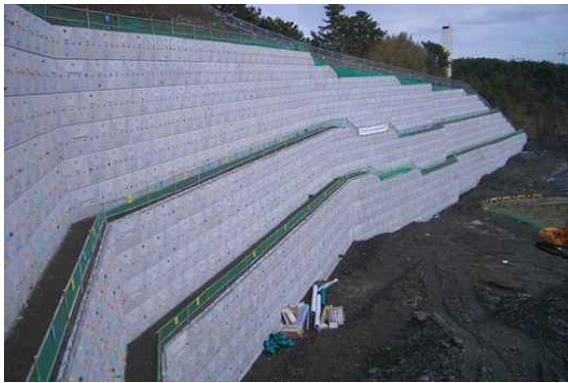
(1) 기존 콘크리트 패널
