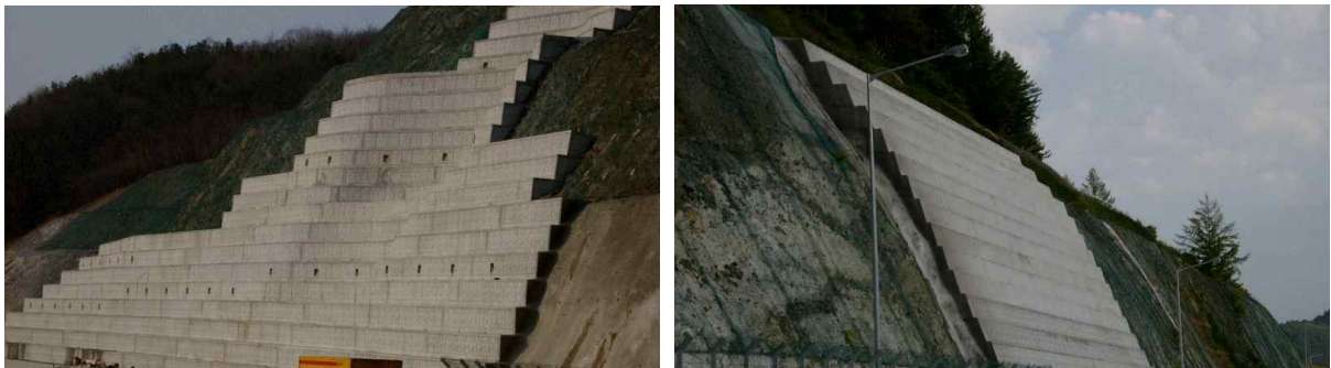
(1) 도로변 콘크리트 옹벽
