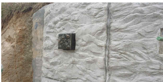
(21) 옹벽 전면판 마감
