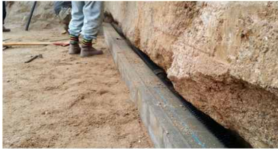
(1) 기초 및 유공관 설치
