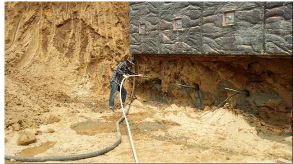
(20) 3단 쏘일네일링 설치 및 그라우팅
