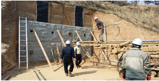
(15) 2단 네일 설치
