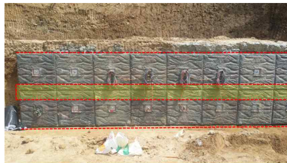
(4) 하부 시공 완료
