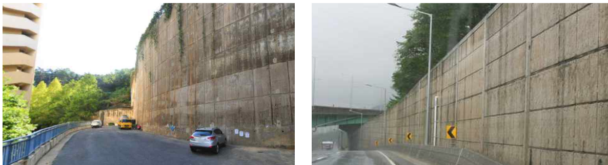
(2) 주거지역 및 도심지 콘크리트 옹벽
