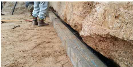
(7) 기초블록 및 유공관 설치
