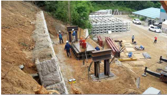
(9) Support Beam 설치
