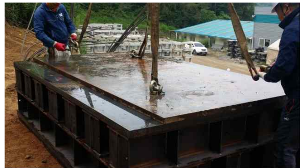
(6) 상부 재하판 설치
