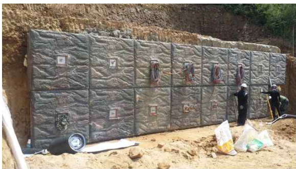
(15) 2단 패널 설치
