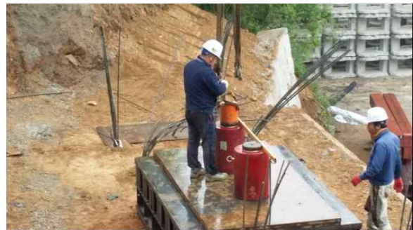
(8) Load Cell 설치
