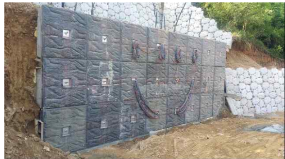
(24) 3단 몰탈 뒤채움 및 시공 완료
