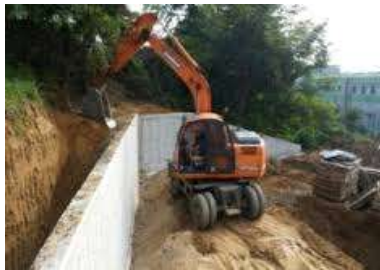
(1) 터파기 및 되메움
