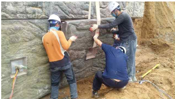
(23) 3단 패널 설치
