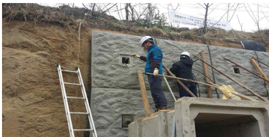
(19) 3단 네일 설치 및 그라우팅
