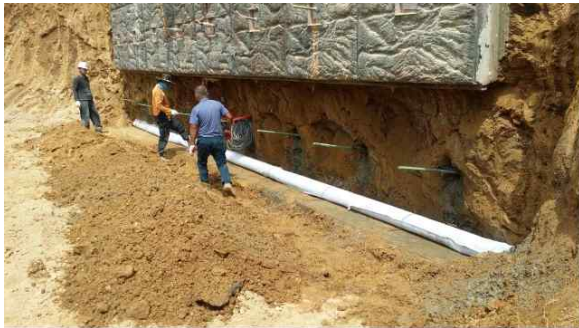
(21) 기초콘크리트 타설 및 유공관 설치
