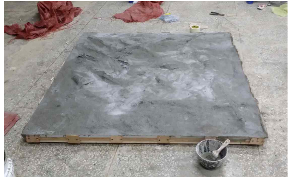
(2) 고강도 시멘트 기초타설 작업
