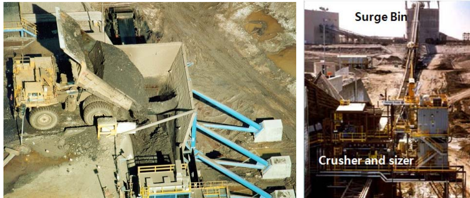
[그림 2.27] Ore Preparation Plant (OPP)
