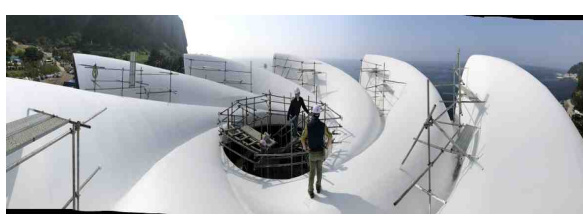
[지붕 마감 공사]
