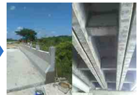
교량 가드레일 시공
