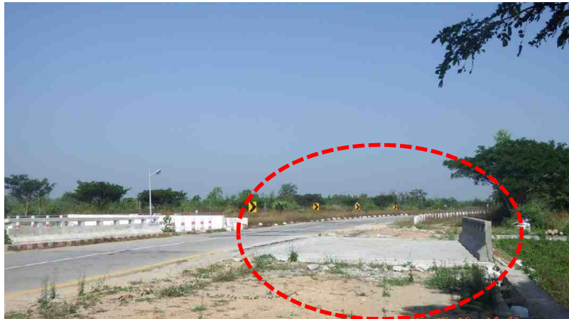
[미얀마 M-UHPC Bridge (원 안의 교량 부분)]
