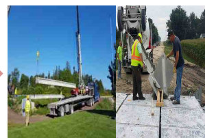
조립 및 연결부 타설
