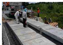
M-UHPC 거더 조립
