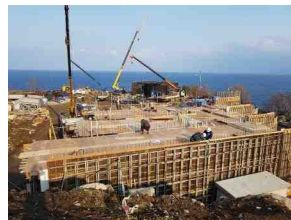
[B동 1층 타설]
