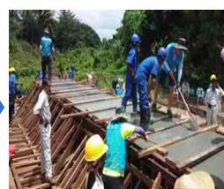
M-UHPC 거더 타설
