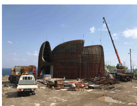
[A동 2층 거푸집 조립]
