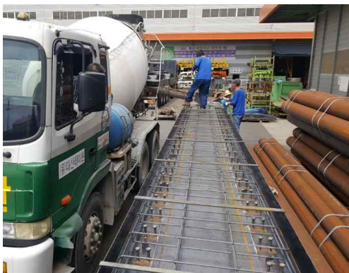
그림 4. 수평 절곡강판 거더 합성연결부 접합부 제작 사진
