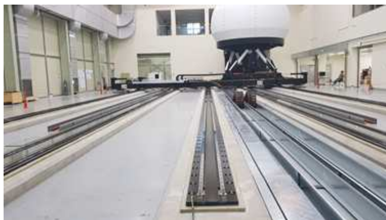
X-Rail 설치 사진
