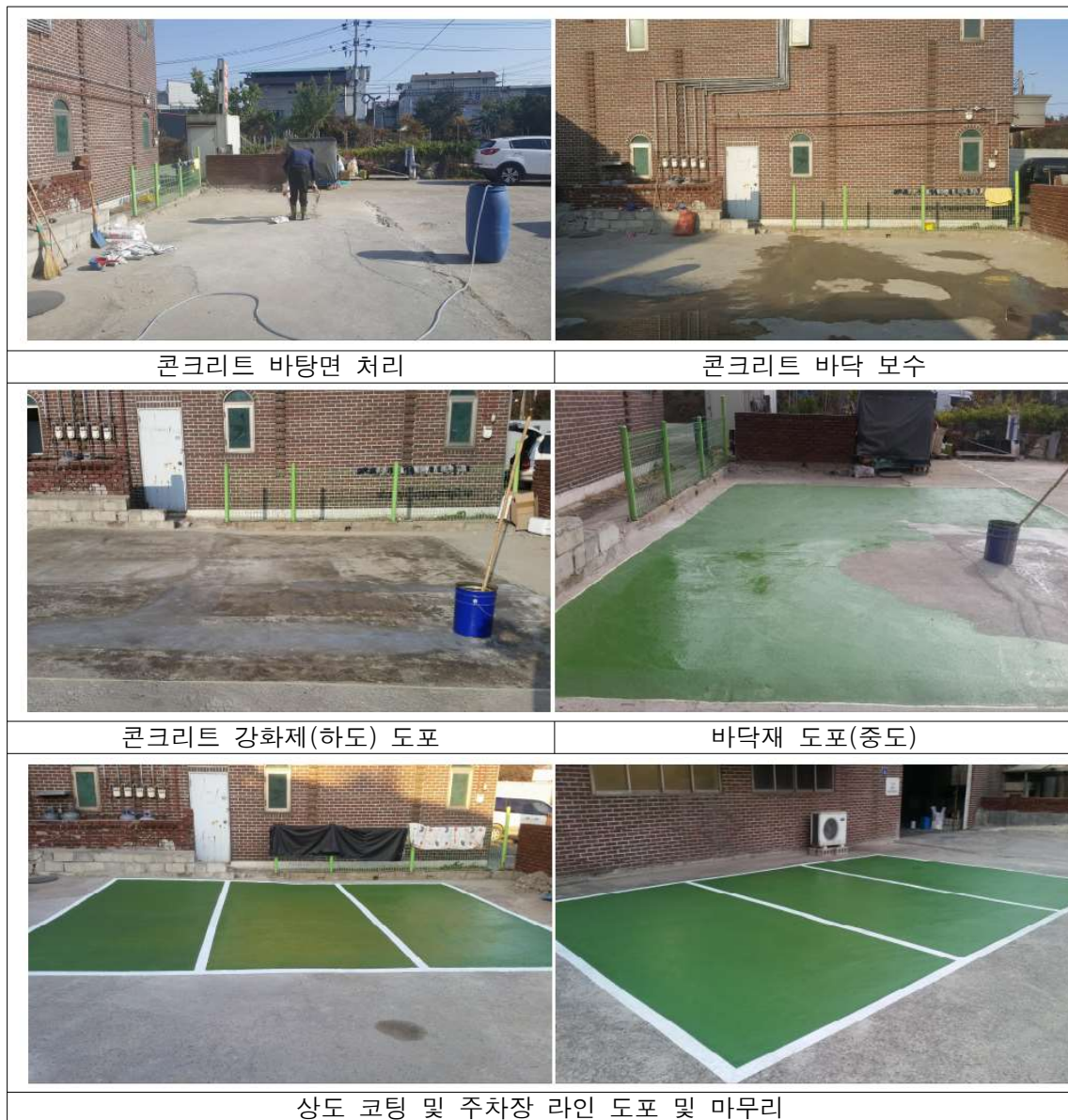
그림 46. 현장적용 성능평가를 위한 시공 순서
