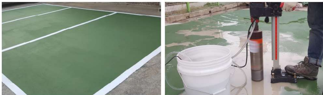
그림 47. 주차장 바닥 마감재 시험시공 및 코어채취
