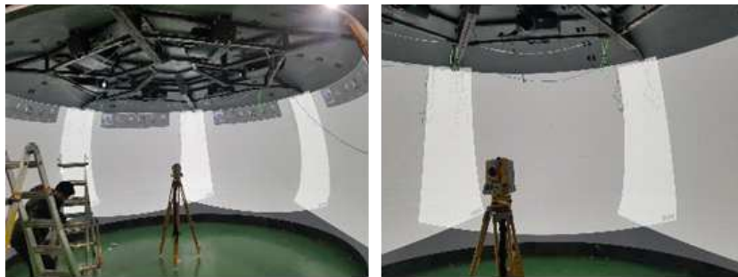
<그림 3.2.54> 프로젝터 영상 투사 화면 크기 및 위치 셋팅
