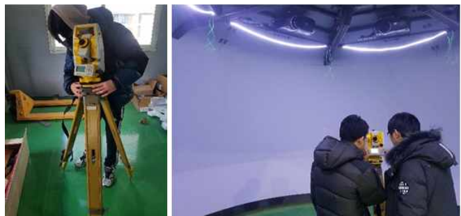
〈그림 3.2.52〉 광파기 설치 및 셋팅
