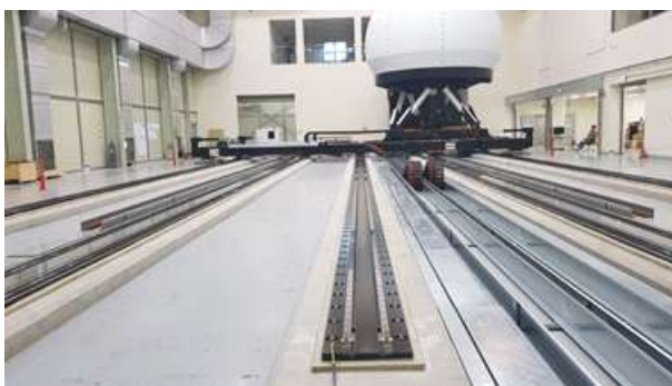
<그림 3.2.37> X-Rail 설치 사진
