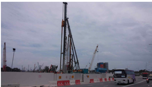
<그림 6.4> DSM 시공현장
