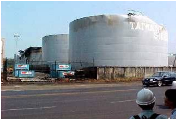
그림 3. 대만 당밀 저장탱크 안전사고 (1999.10.01) (원인: 지진에 의한 지반 액상화)
