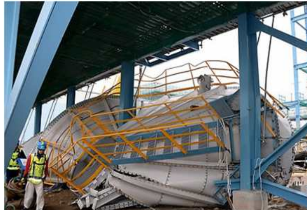
그림 2. 울산 물탱크 안전사고(2013.07.26) (원인: 볼트 연결부의 파열)
