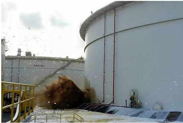
그림 1. 울산 원유탱크 안전사고(2014.04.04) (원인: 균열로 인한 원유유출)
