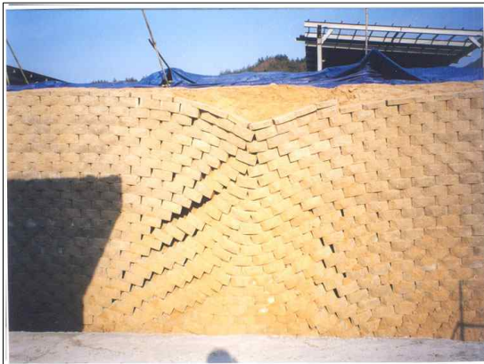
그림 3.1.23 춘천시 경춘국도 입구 보강토옹벽의 피해모습
