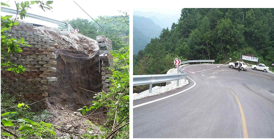
그림 3.1.18 강원도 영월 지방도로 보강토옹벽의 피해 모습
