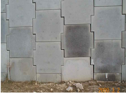
그림 3.1.22 경주 OO공장 부지조성 보강토옹벽의 피해 모습
