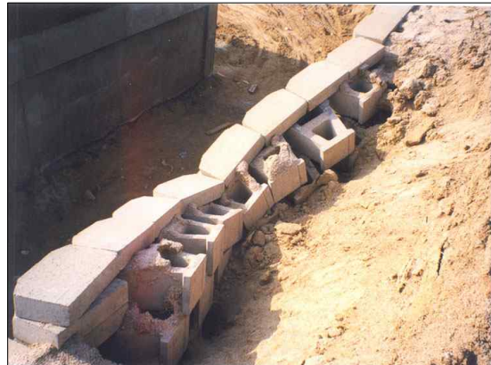
그림 3.1.23 춘천시 경춘국도 입구 보강토옹벽의 피해모습
