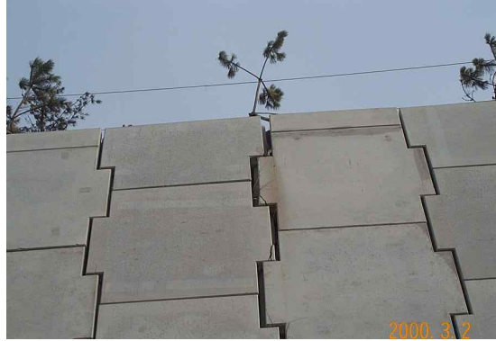
그림 3.1.22 경주 OO공장 부지조성 보강토옹벽의 피해 모습
