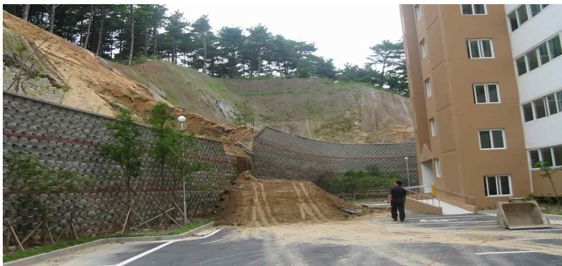
그림 3.1.20 동해 OO아파트 보강토옹벽의 피해모습
