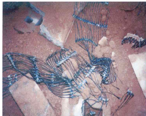
그림 3.1.3 광주시 OO중학교 보강토옹벽의 붕괴 모습
