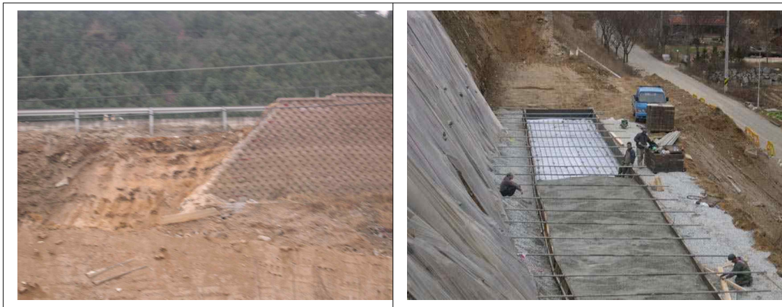
그림 3.1.4 경춘국도 OO휴게소 부근 보강토옹벽의 붕괴모습
