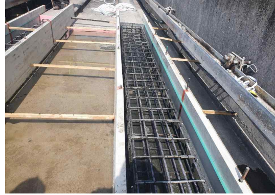
주행로 거꾸집 설치
