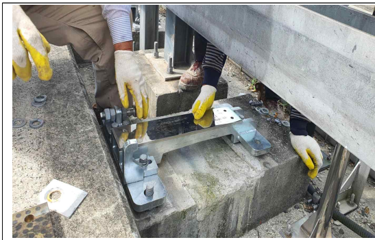
개량형 수대 설치
