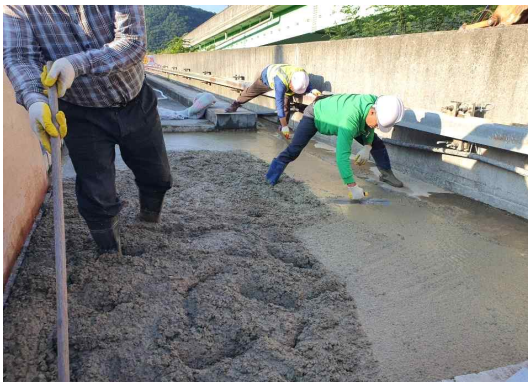
하부 콘크리트 타설
