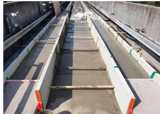
주행로 콘크리트 타설후
