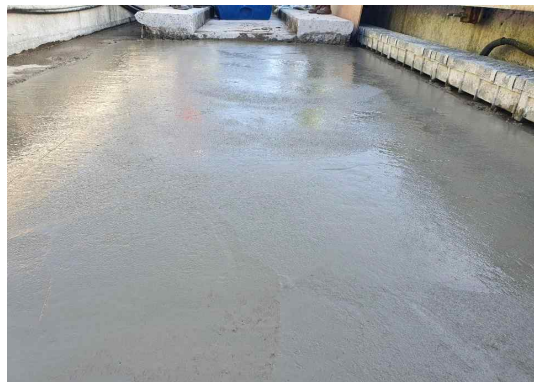
하부 콘크리트 타설완료
