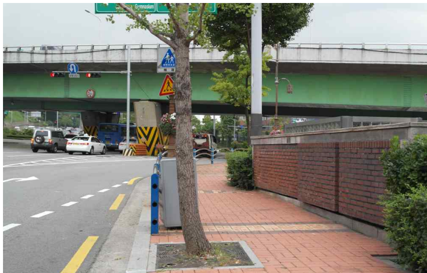
<그림 2.6> 지하철역 주변 철도시설물과 도로
