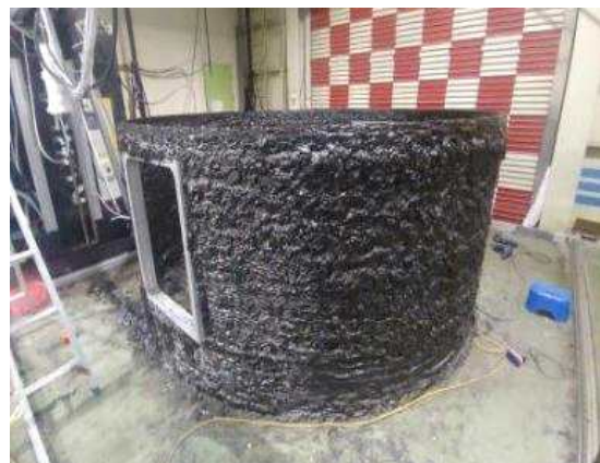
적층, 레벨링 사출 최적화 과정을 통한 구조물 제작 과정
