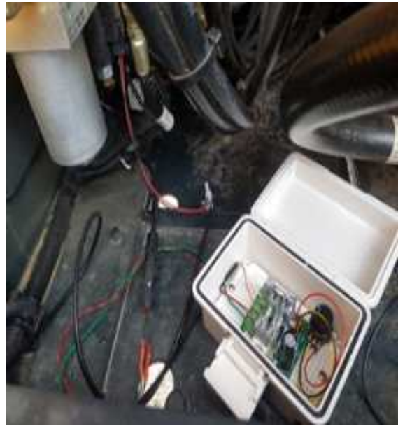
<굴삭기 전자제어모듈 설치>
