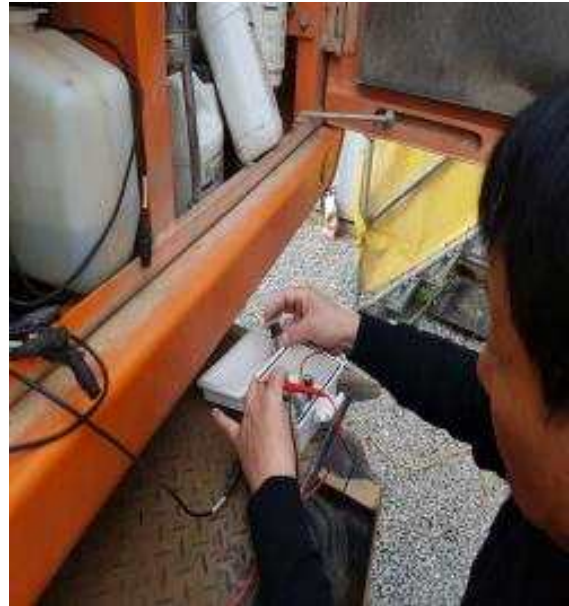
<굴삭기 전자제어모듈 설치>
