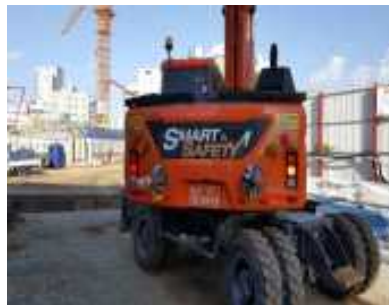
< 협착 방지봉 설치>
