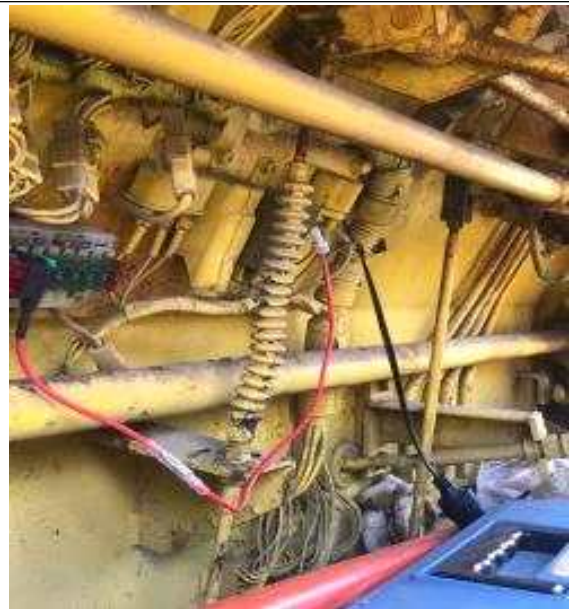
<포장장비 전자제어모듈 설치>
