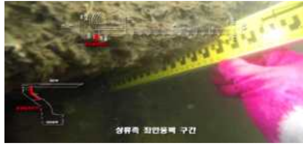
침식 및 철근노출(A=2.0m × 0.7m, T=300mm)
