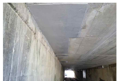
천정 부분보수 완료
