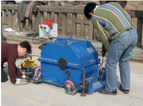
(c)실교량 가진기 설치
