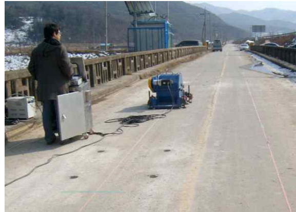
(d)실교량 가진실험 전경
