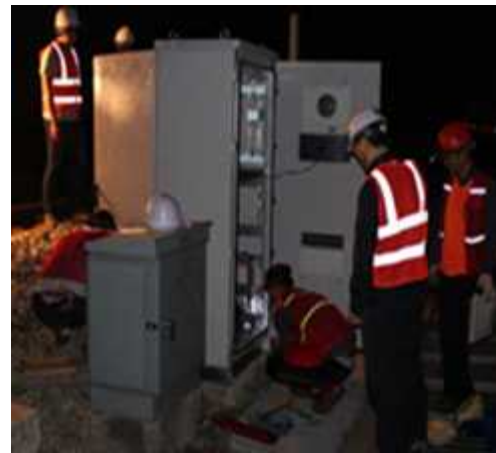
[ 전자랙 설치 및 점검 ]
