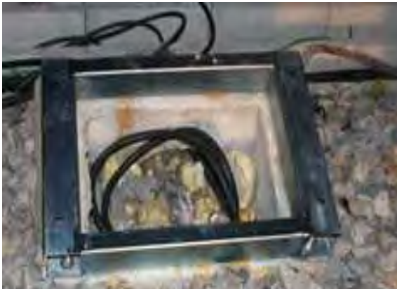
[ 전자랙 설치 지그 취부 ]
