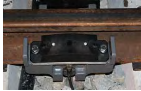
[ 전자폐달 설치 완료 ]
