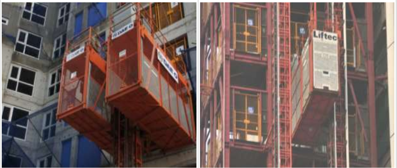
그림 28. 건설현장에서 사용되는 렉기어타입 인화물용 EV
