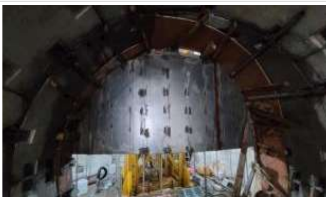
그림 26. 수직구 하부 횡갱 접속부 슬립폼 시공 전경, 로드를 매설할 수 없는 횡갱접속부
