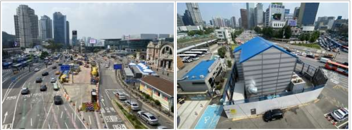
그림 102. 도로내 부지확보로 교통이 불편한 지하시설물 공사
