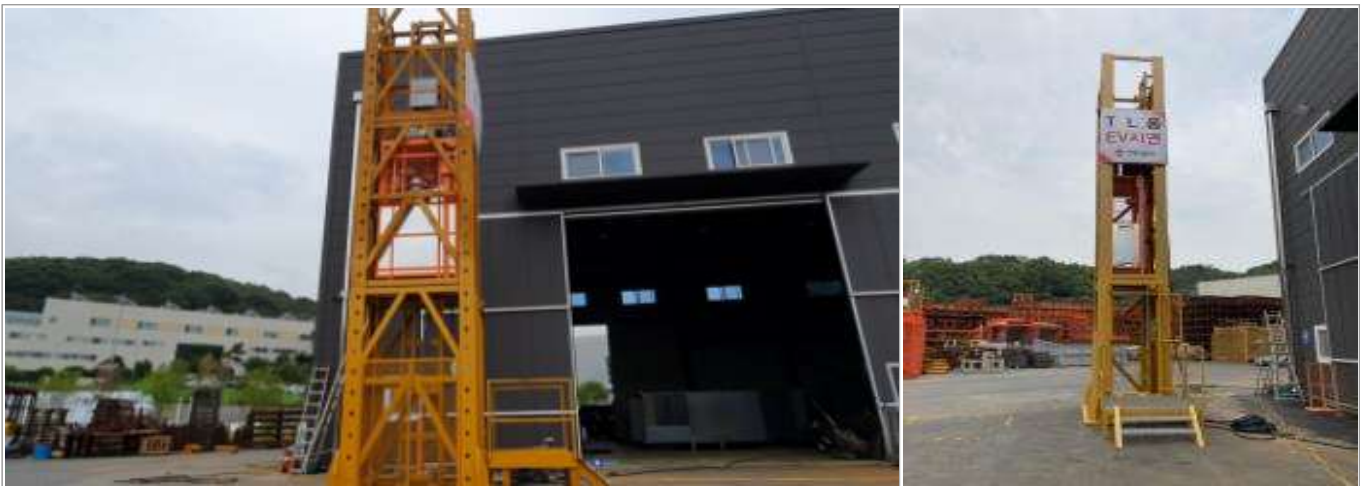
그림 41. 인화물 호이스트 시운전 (타워내부 엘리베이터)
