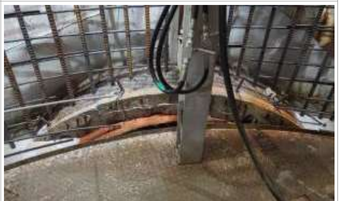
그림 26. 수직구 하부 횡갱 접속부 슬립폼 시공 전경, 로드를 매설할 수 없는 횡갱접속부
