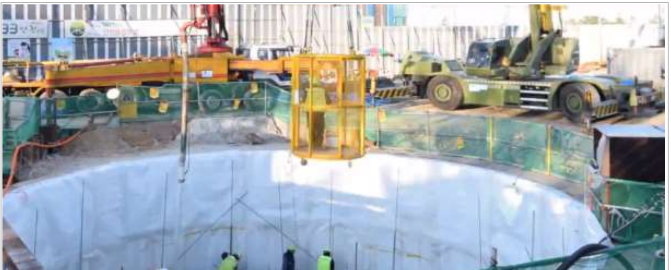
그림 23. 슬립폼으로 작업자를 위법적으로 이동시키는 전경
