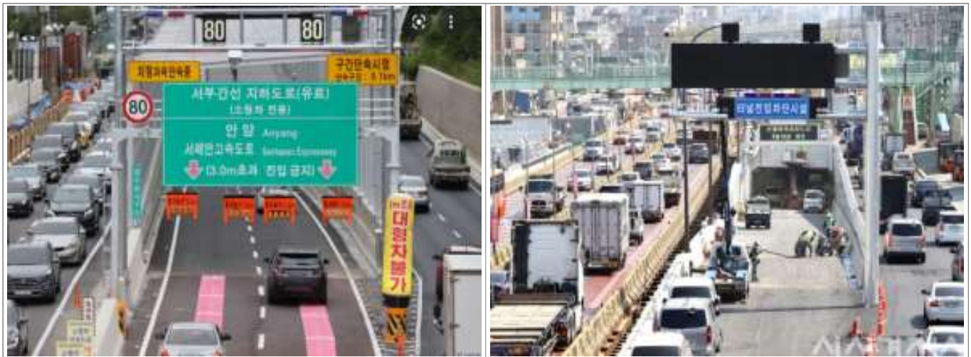
그림 105. 최근 개통된 서부간선지하도로(좌), 제물포터널(우) 전경
