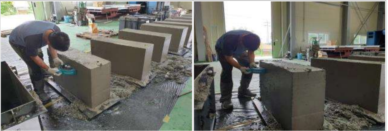
그림 67. 콘크리트 반발력 측정 전경
