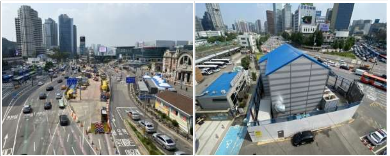
그림 19. 도로내 부지확보로 교통이 불편한 지하시설물 공사
