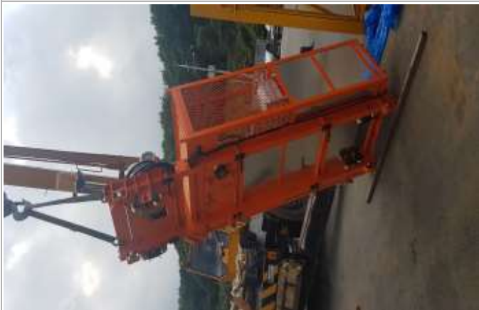
그림 78. 타워 내부 조립 및 설치 전경 (타워 내부 엘리베이터)
