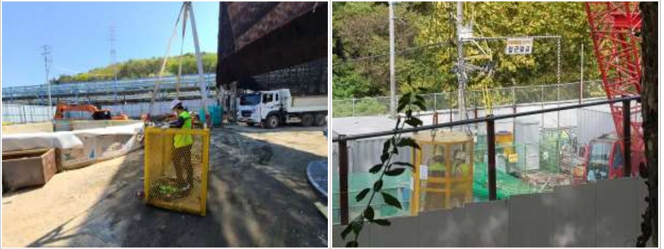
그림 21. 작업자를 수직구 내부 슬립폼으로 이동시키기 위한 산업안전보건법 위반 전경
