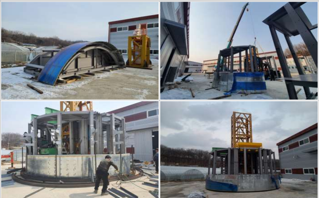
그림 100. 타워 구조물 이용한 슬립폼 시제품 전경
