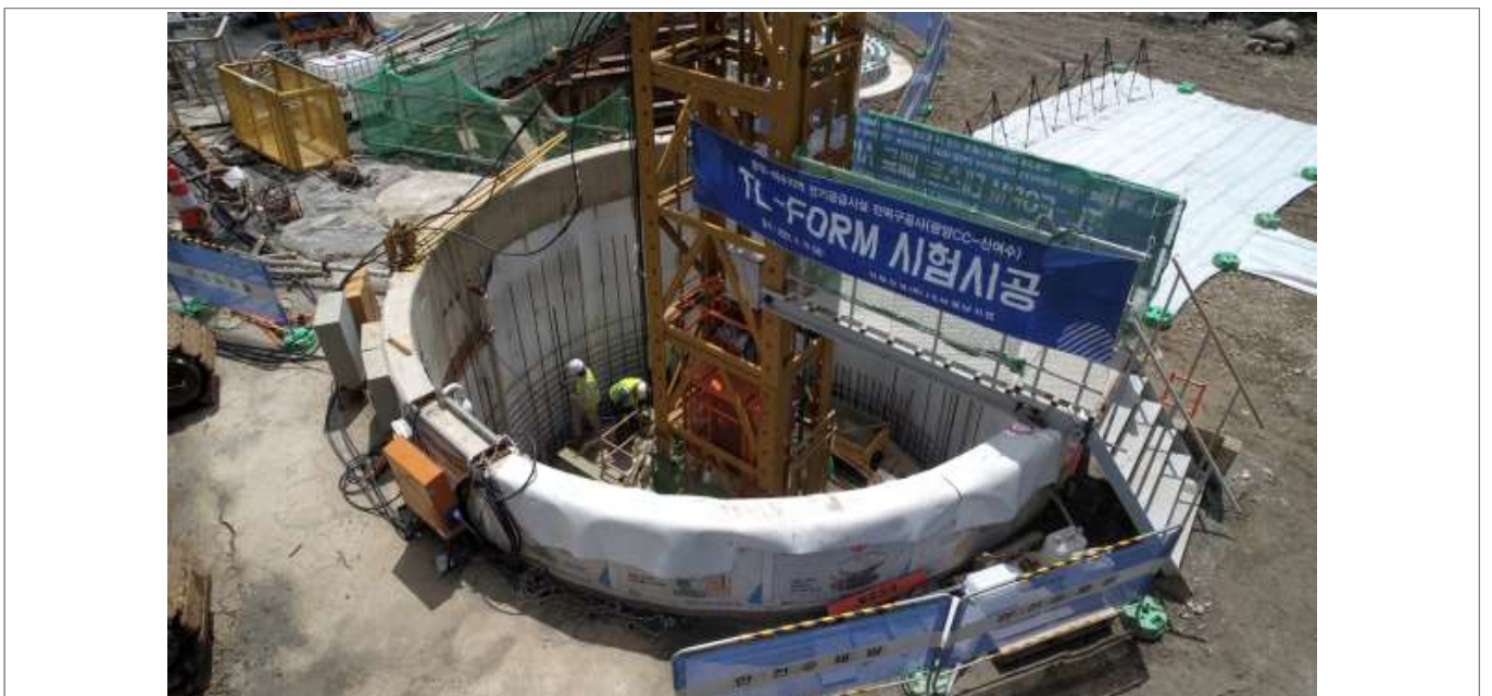
그림 101. 사회적 요구에 부응하는 수직구 신공법(TL-FORM) 공법
