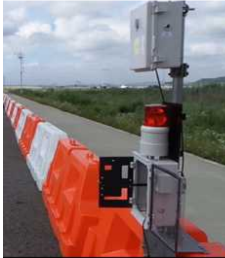
<그림 3.72> 경광등 설치
