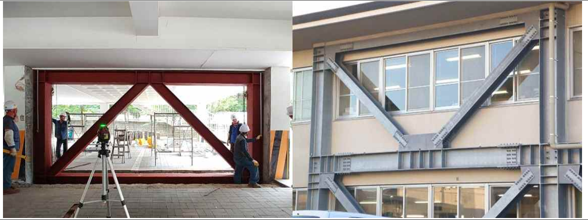
[그림] 철골브레이스 내부설치(좌), 외부설치(우)
