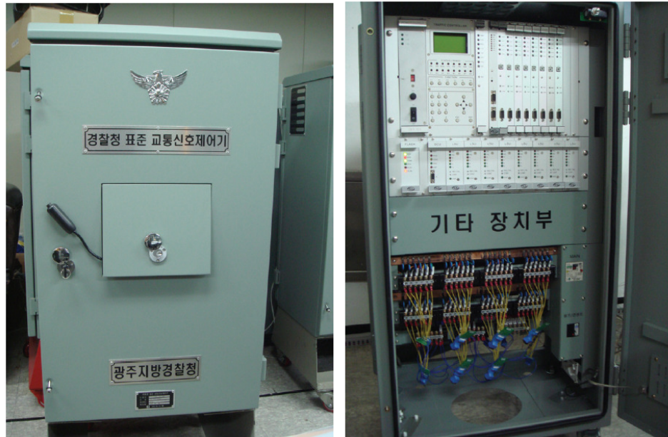
그림 .2- 32 표준규격 교통신호제어기 함체 및 내부구성 예
