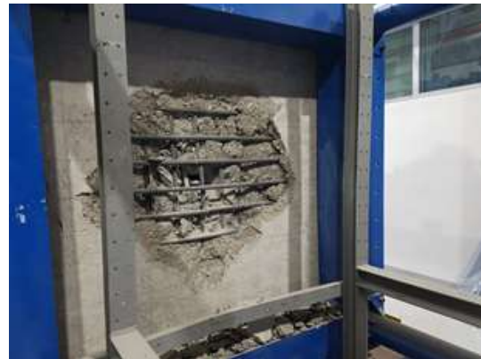
그림 3.4 충돌하중에 의한 콘크리트 벽체의 배면파쇄
