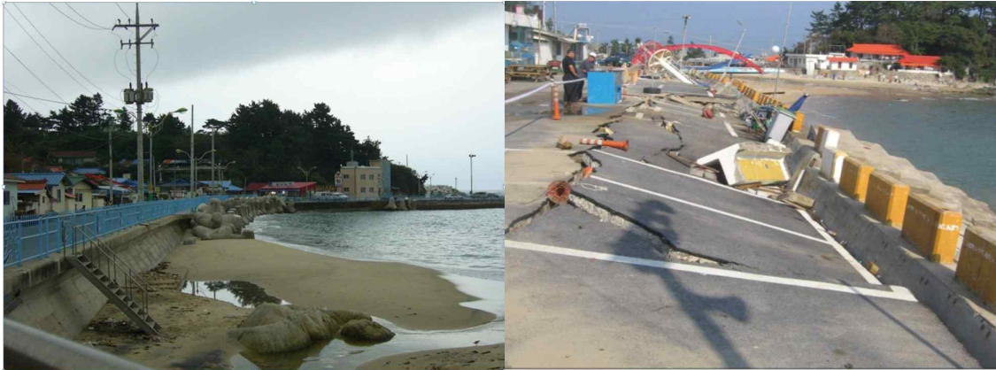
<그림 2-14> 고파랑에 의한 호안 침식피해 현황
