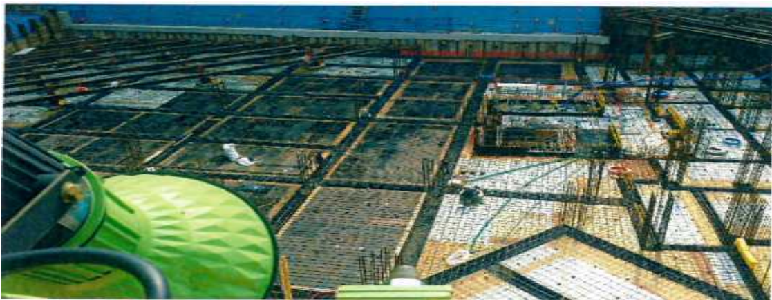
[사진 2-5] 테이블 슬래브 시스템 설치 전경
