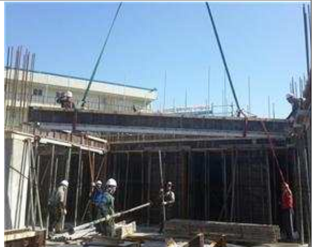
[시공순서 사진 1-6] 테이블 보 설치
