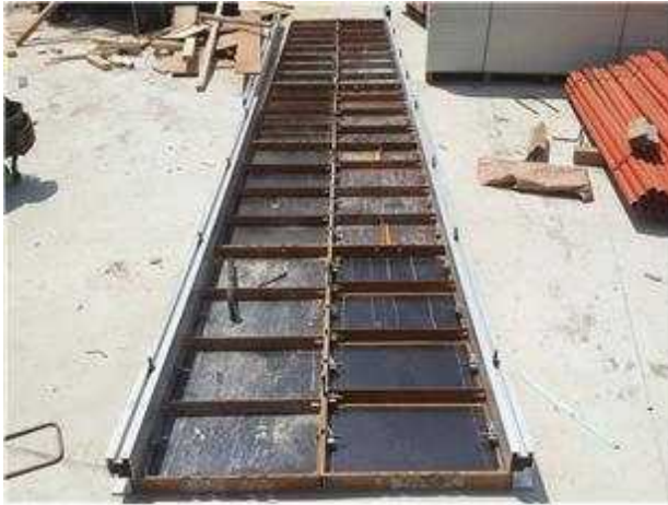
[시공순서 사진 1-1] 보 바닥(슬래브)와 팀버연결 연결
