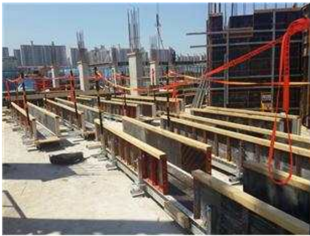
[시공순서 사진 1-5] 테이블 보 제작 완료
