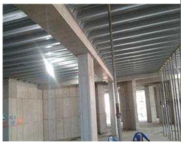
[시공순서 사진 1-9] 테이블 보 타설, 해체 후 모습
