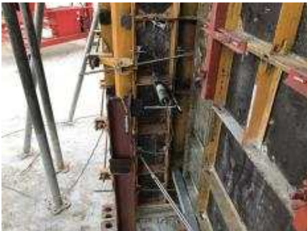
[그림. 15] LVDT-4 설치현황
