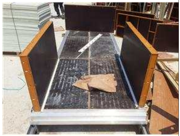
[시공순서 사진 1-2] 보 옆판(측면)과 팀버연결 설치
