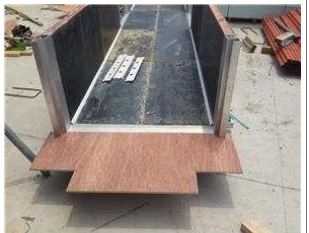
[시공순서 사진 1-2] 보 옆판(측면)과 팀버연결 설치
