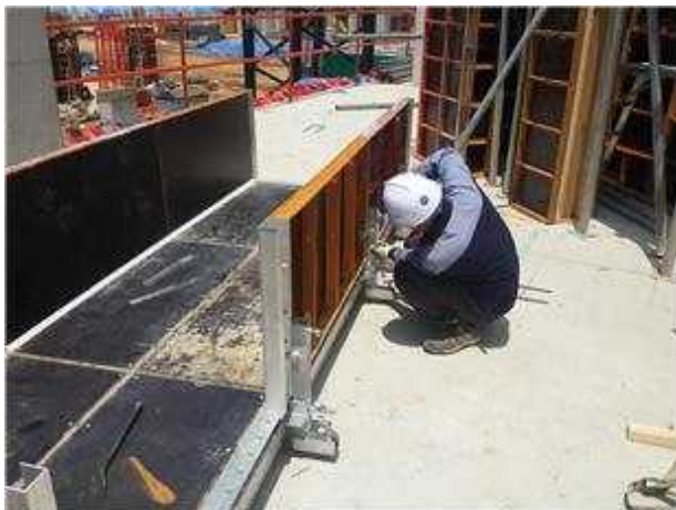
[시공순서 사진 1-1] 보 바닥(슬래브)와 팀버연결 연결
