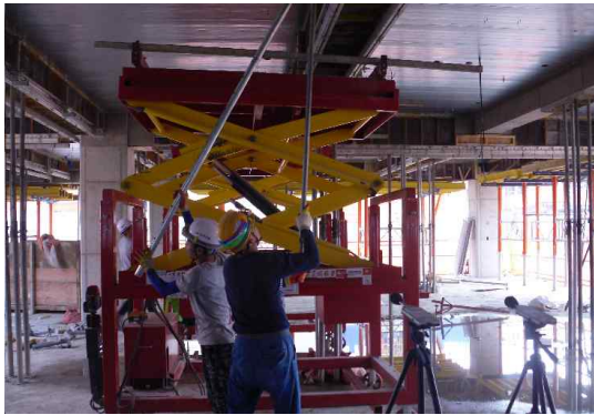
본 신청기술 측정사진 <그림 3.23> 해체작업 상황
