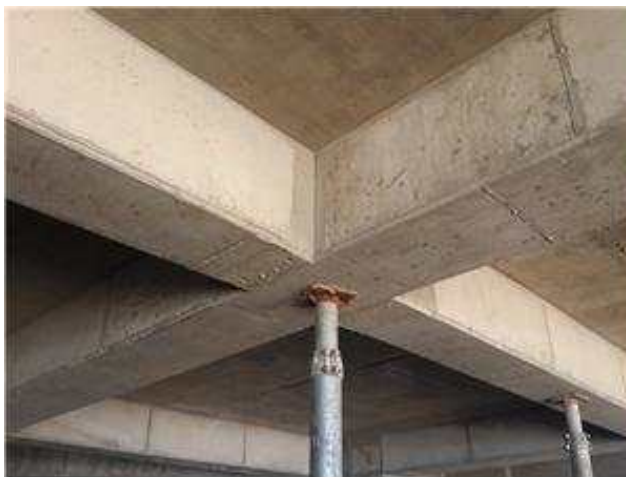
[시공순서 사진 1-9] 테이블 보 타설, 해체 후 모습
