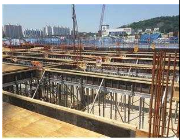
[시공순서 사진 1-8] 테이블 보 설치 완료 후 전경
