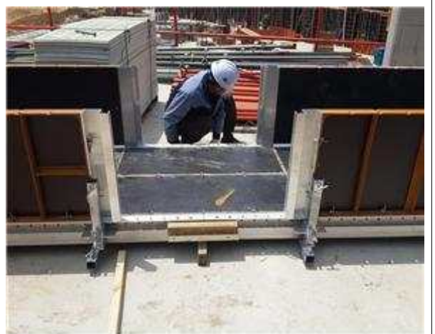
[시공순서 사진 1-4] 보 G보, B보 바닥(슬래브) 마감
