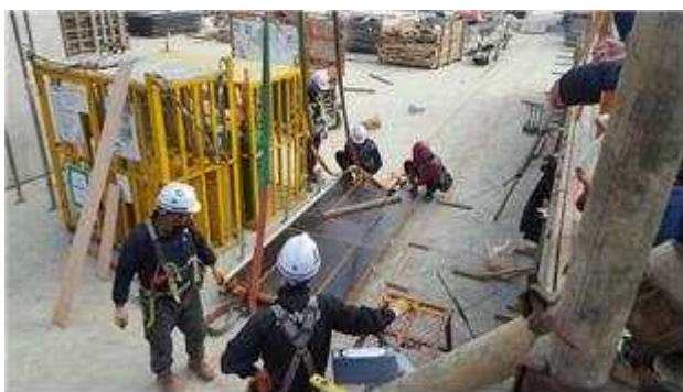
[사진 2-7] 테이블 슬래브 시스템 대림 하남 미사 센터 비즈 샘플 시공
