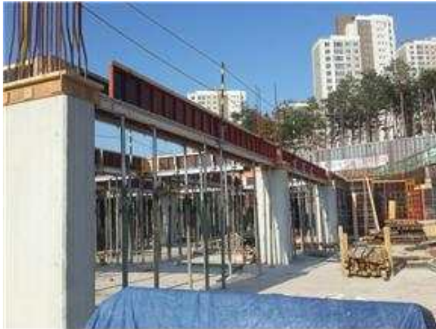
[시공순서 사진 1-7] 테이블 보 설치 완료
