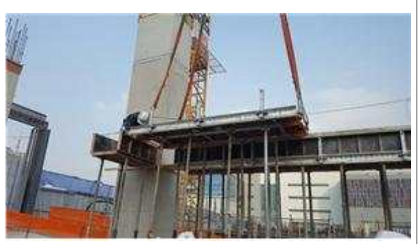
[사진 2-7] 테이블 슬래브 시스템 대림 하남 미사 센터 비즈 샘플 시공
