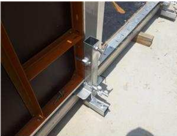
[시공순서 사진 1-3] 보 브라켓 설치
