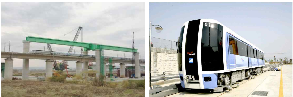
그림 16. 호남고속철도 오송고가 건설구간(左), 부산3호선 반송선 경전철(右)
