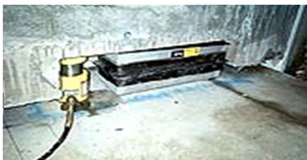
그림 46. 부천역사에 설치된 플로팅 슬래브궤도
