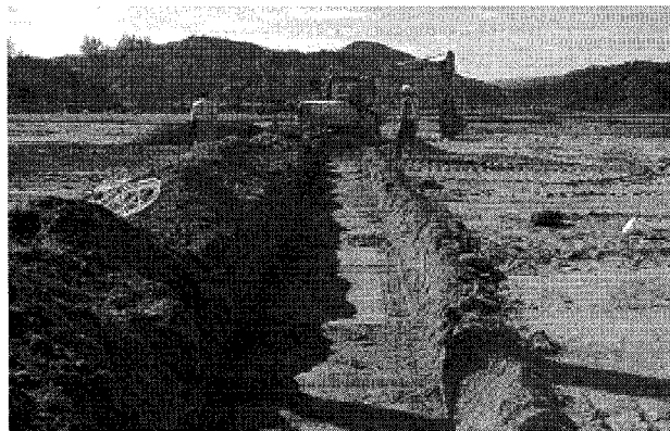
<그림 3.8> 튜브 및 케이블 포설을 위한 관로 확보
