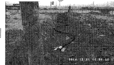
4. 센서부에 Plat와 보호대를 연결한 후 설치지점에서 기준수조까지 Sand Mat의 중간에 약 20~30cm 정도 깊이의 관로를 확보한 후 그 림과 같이 침하계를 포설을 한다
