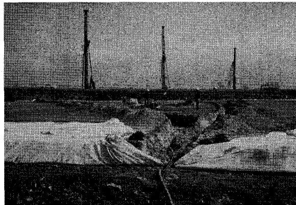
<그림 3.10> 배수로 통과부분에 대한 보호관 작업
