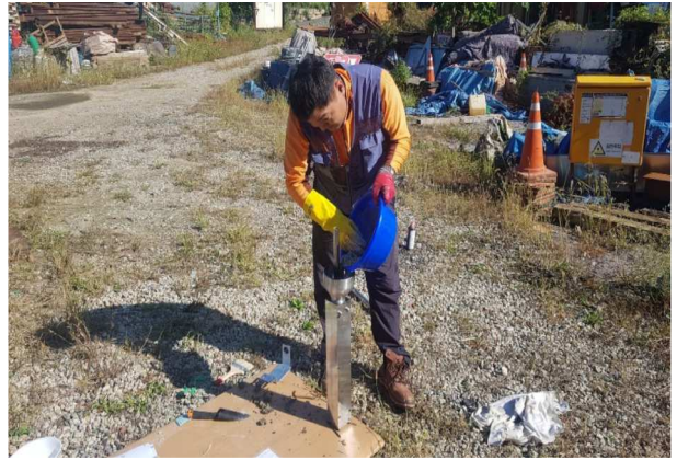
그림 2-21 하우징 재료 혼합 및 지그에 투입
