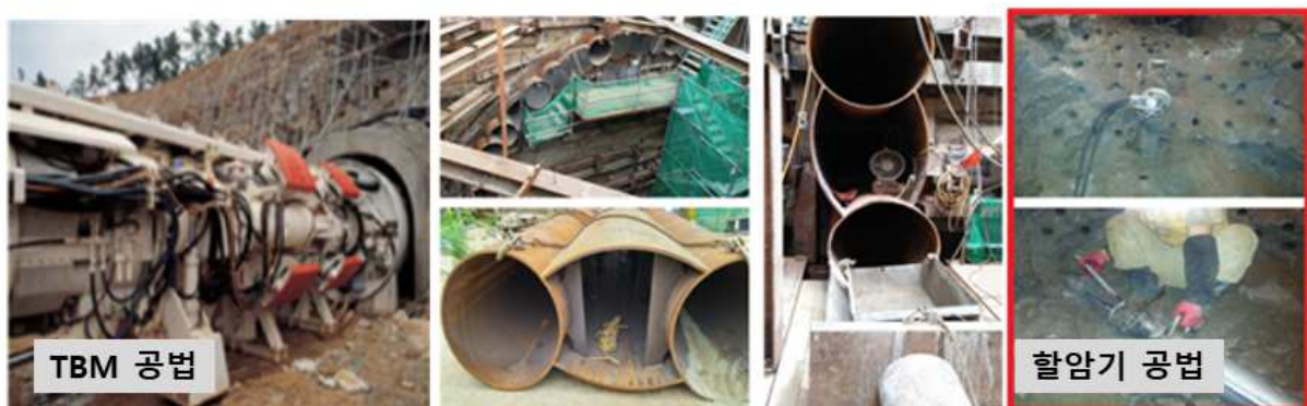
[그림 1-1] 기존 무진동 암반파쇄 기술 예
