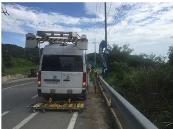
<국도 공동조사 현장 전경>
