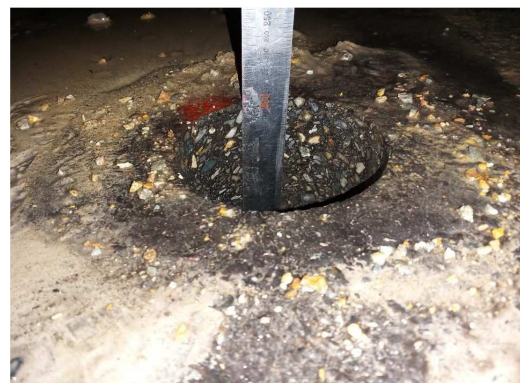
<코어채취 후 포장두께 측정>
