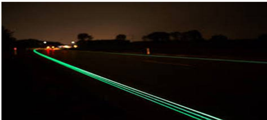
그림 2. 축광 현상을 도입한 네덜란드 회사의 프로토 타입 도로. 수막현상으로 인한 재귀반사 효율의 저하를 근본적으로 해결할 수 있음.
