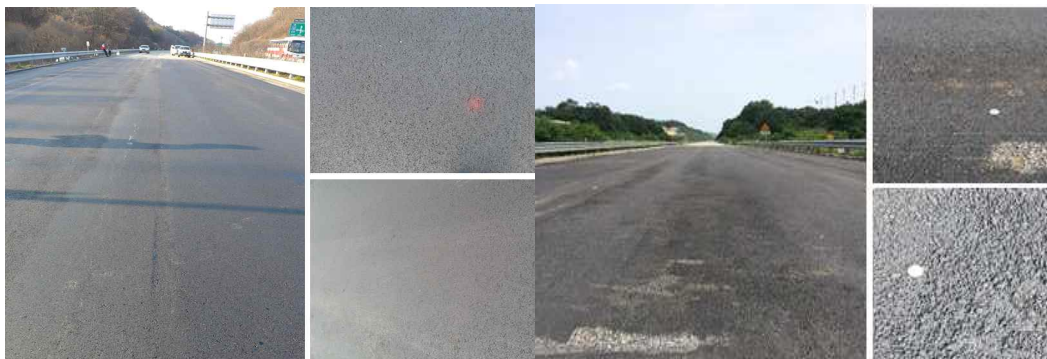
<그림 3-52> 시공 직후 및 4개월 후 포장 상태
