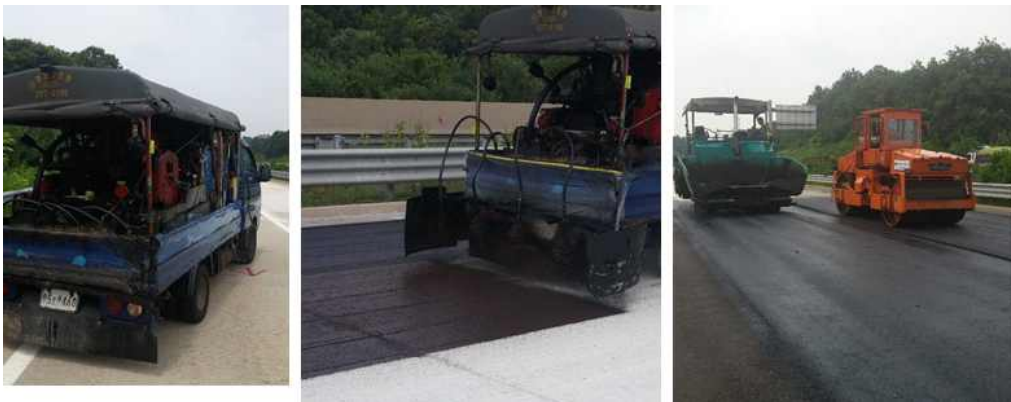
<그림 3-58> 기존 포장 위 텍코팅 유제 도포
