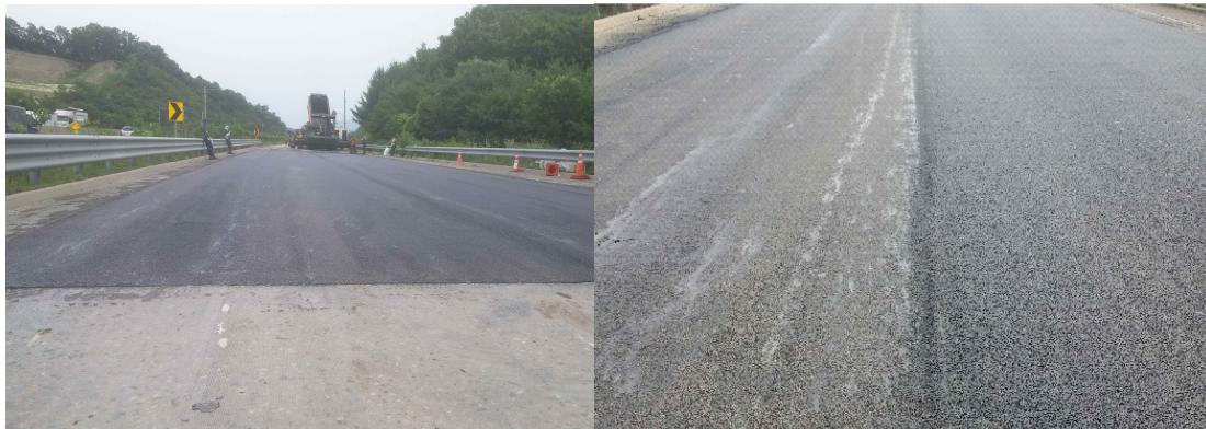
<그림 3-59> (좌) JCP 위 F-DGM 시공 후, (우) CRCP 구간 2차 시험시공(F-SMA&F-PFC)
