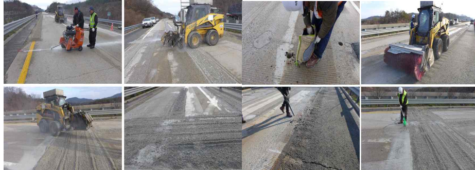
<그림 3-43> 시공 구간 단부 및 <그림 3-44> 기존 CRCP 포장 표면 도로표지용 페인트 절삭 모습 청소 모습
