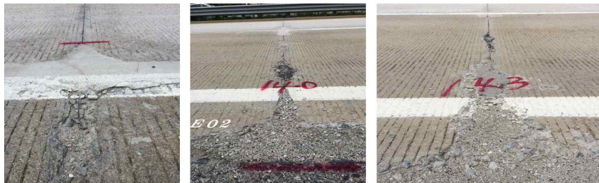
<그림 3-53> 시험시공 전 JCP 구간 포장 상태
