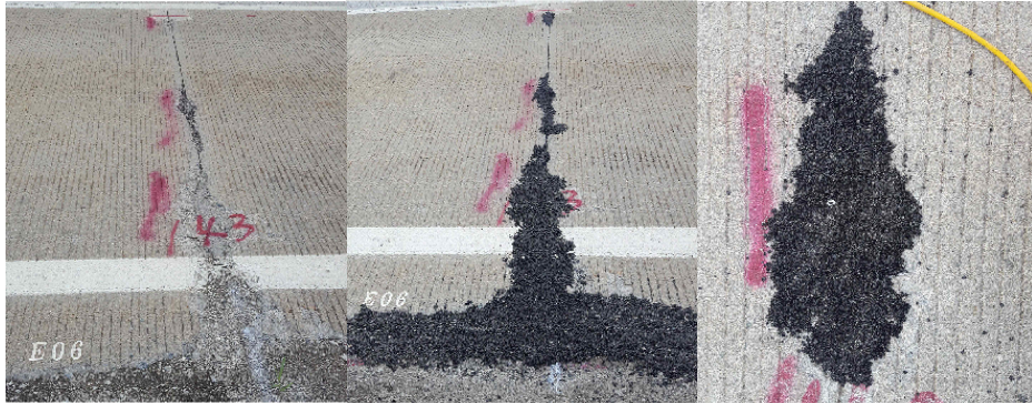
<그림 3-57> 기존 JCP 스폐링 파손 부위 부분 보수
