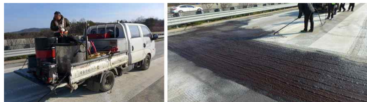
<그림 3-45> Tack Coat 살포 시공 과정
