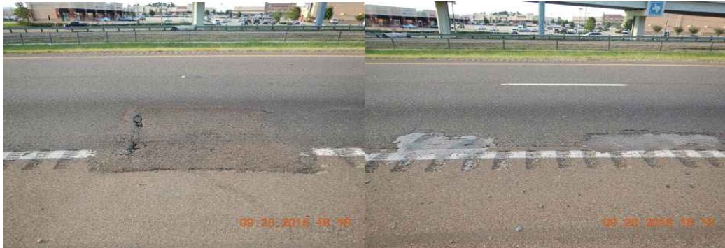
<그림 3-71> 기존 CRCP의 모서리 펀치 아웃으로 인한 결함
