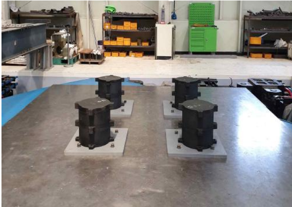
(a) 면진장치 설치
