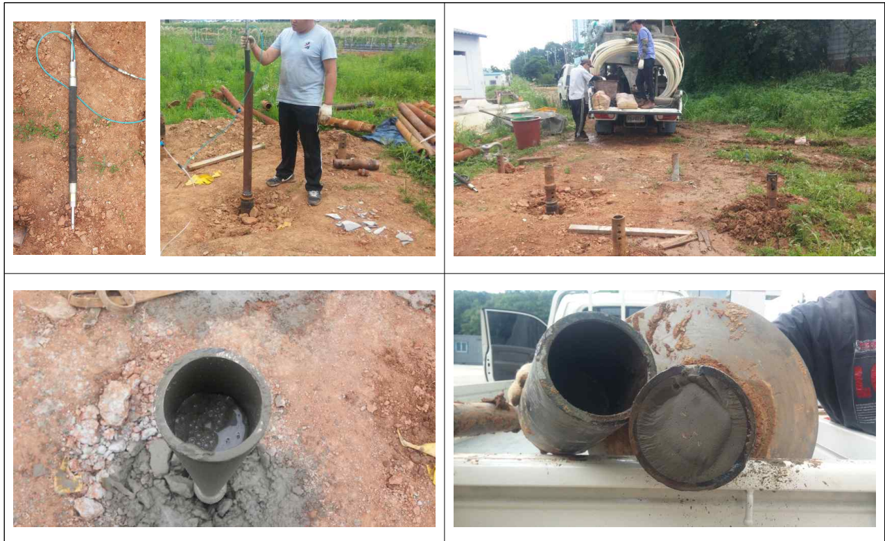
그림 2.3.3.71. 개발한 지반보강 헬리컬 파일 시공
