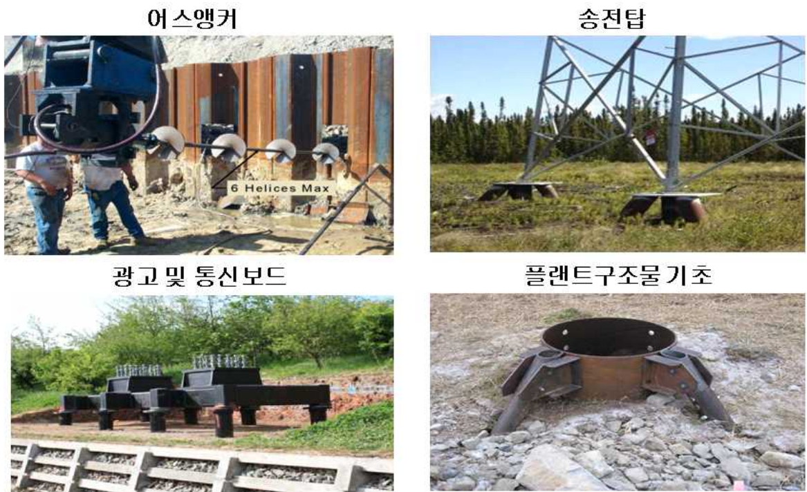
그림 1.1.1.1 helical pile의 적용사례
