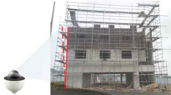
그림 2. 준공 중 건물 및 가설재 변위측정
