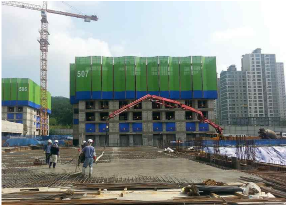
(a) 2층 바닥 슬래브 타설
